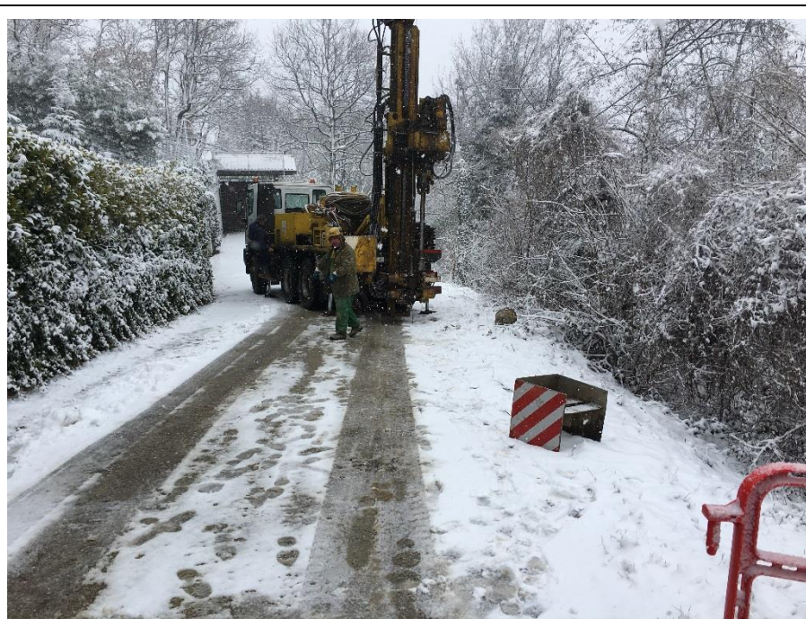
Fig. 5. Indagini geologiche/geotecniche – Sondaggio a carotaggio continuo
